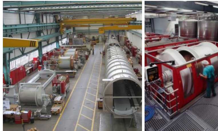
Fruchtsaft- und Trocknungsanlagen
