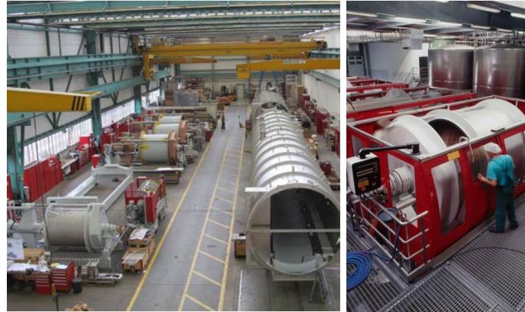
Fruchtsaft- und Trocknungsanlagen
